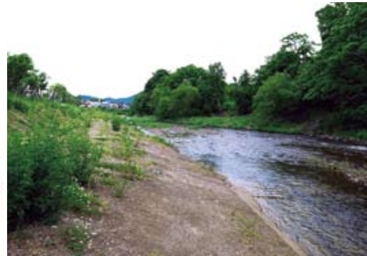
北海道札幌市の真駒内川。左岸のみ拡幅し、護岸は立てて水際から遠い位置に入れている。
