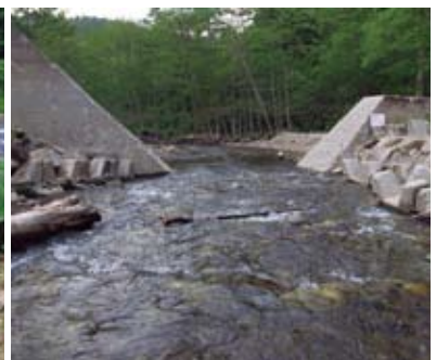
堰堤の一部を切り下げた北海道標津町のイケシヨマナイ川。上流からの土砂供給によって川底に礫河原が回復した。
