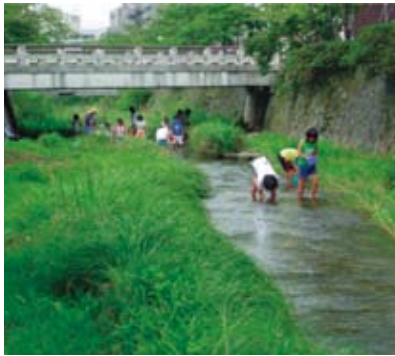
山口市の一の坂川ホタル護岸。1971年の水害を契機に、ゲンジボタル再生を目指した河川改修を実施。右は施工直後、左は近年の様子。（写真=2点とも山口県土木建築部河川課）
